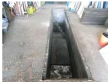
État actuel – travée avec fosse
